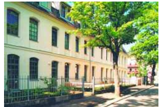
Nordstraße (alte Druckerei), Lofts
